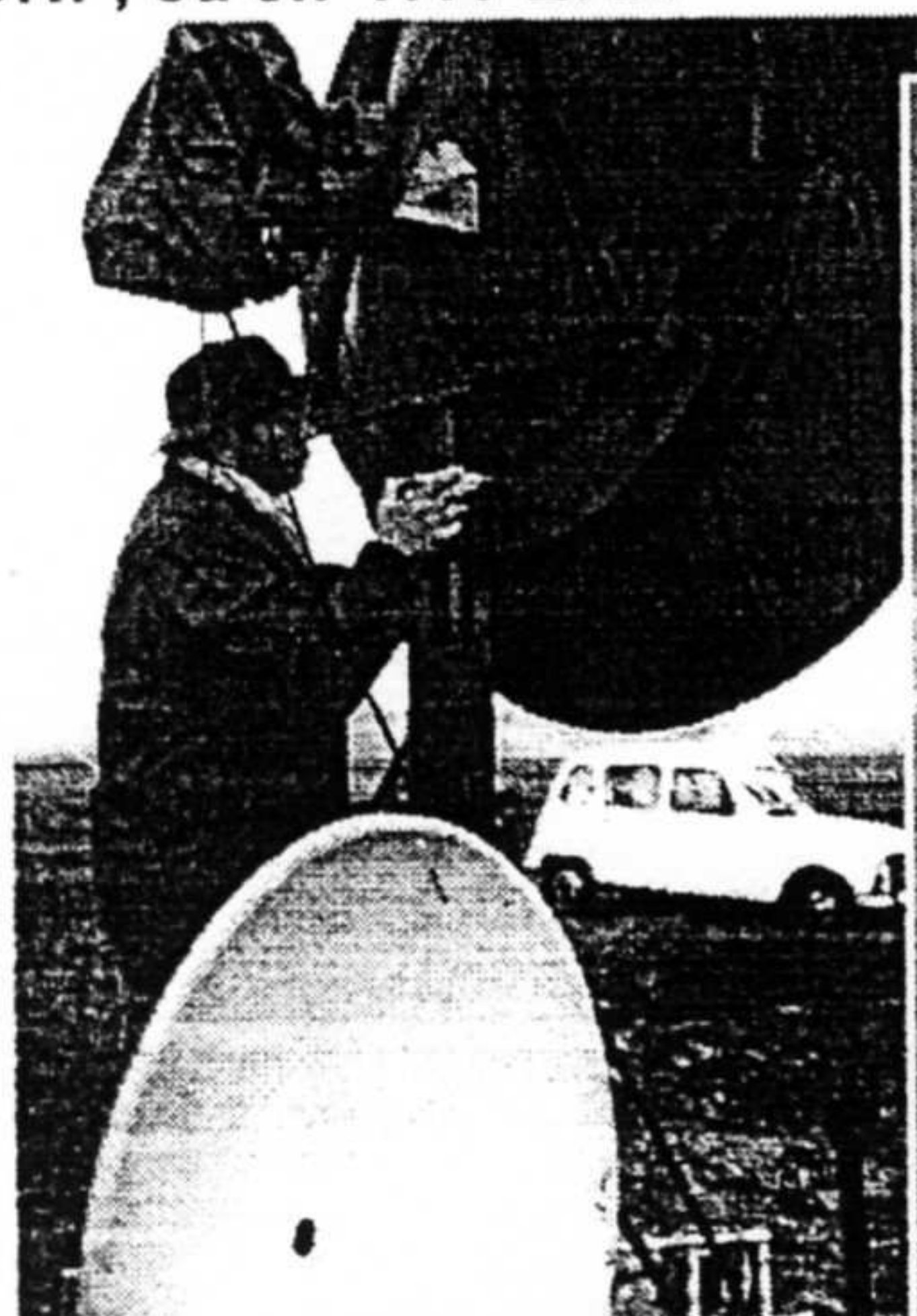
Calibration minutieuse de l'azimut. Parabole D=180cm.
