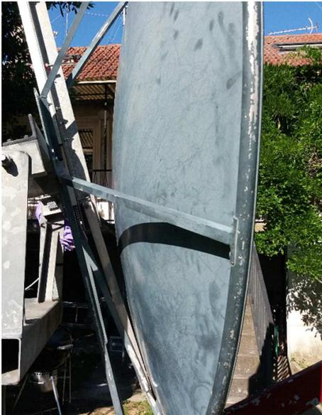
Comme c'est visible sur la photo, la monture est fournie et donne directement l'information de l'angle d'inclinaison utilisé. Hervé l'a mesuré et l'a trouvé égal à 15°.
