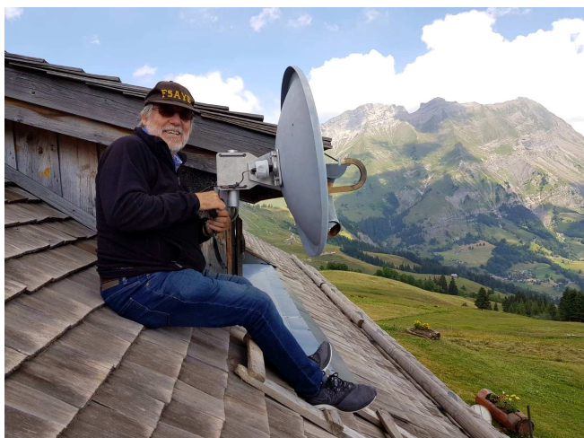
F5AYE installe le coffret
