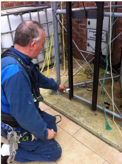
L'OM, F1LPV, en cours de traçage... Eh oui, il fallait prévoir une découpe dans les glissières pour entrer et sortir les guides du chariot... Ouf ! besoin découvert pendant le montage à blanc des glissières sur le pylône... avant leur galvanisation.
