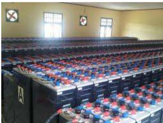
Figure 1. Salle d'accumulateurs au plomb 1000 Ah 230 V [2]
