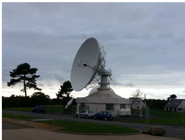
L'antenne PB8 équipée en 24 GHz
