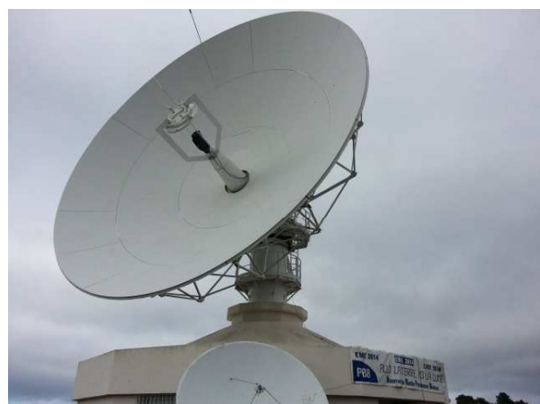
L'antenne PB8 équipée en 24 GHz
