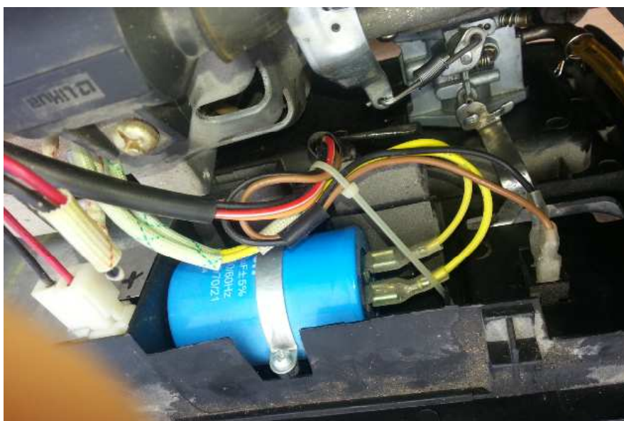
Branchements électriques au panneau latéral
