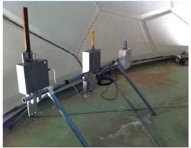
Figure 1 : Installation à la Dôle
