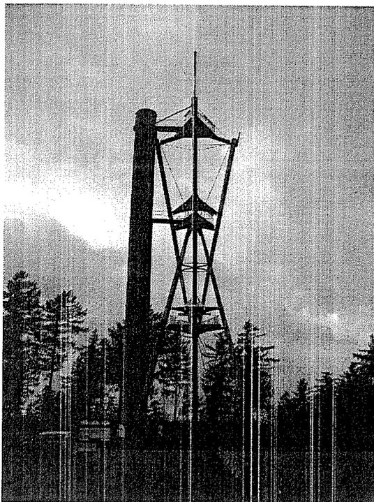
Construite entre mars et septembre 2001, la tour culmine à une hauteur totale de 60m avec 3 niveaux accessibles au public à 15, 30 et 45m. Elle est assemblée à partir de 6 arbres : des Douglas coupés sur place de 3m de diamètre et de 45m de long ainsi qu'une tour métallique renfermant l'escalier en colimaçon permettant l'accès aux 3 plateformes. La masse totale de l'édifice est de 82 tonnes.
